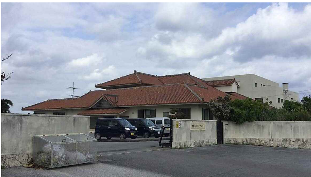
図3-3 宮古島市公共下水道施設の外観
