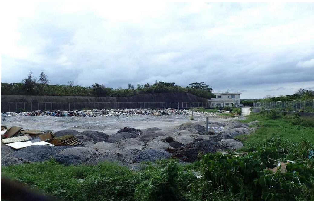
図2-7 川満一般廃棄物最終処分場
